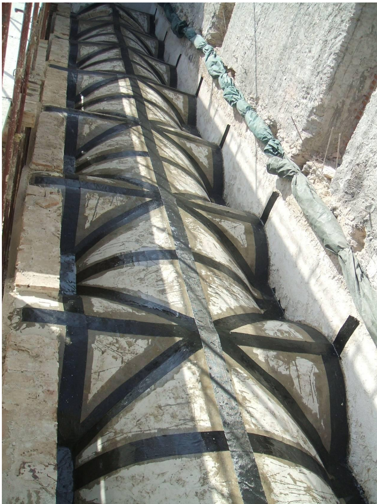
APPLICAZIONE DEI RINFORZI IN CFRP ALL'ESTRADOSSO
