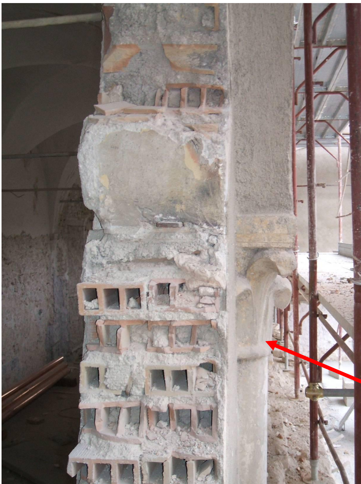
COLONNE INGLOBATE NELLA MURATURA
